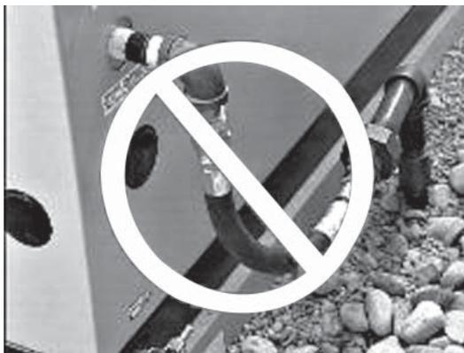
Figura 5.4 — Tendido incorrecto de la manguera flexible
