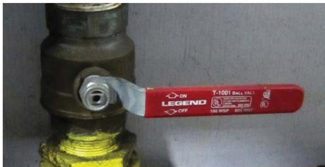
Figura 5.2 — Válvula de cierre de paso total manual
