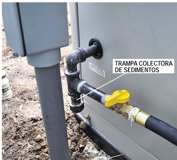
Figura 5.3 — Trampa colectora de sedimentos
