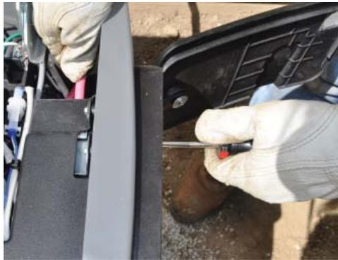
Figura 6.2 — Cableado de la línea principal de CA
