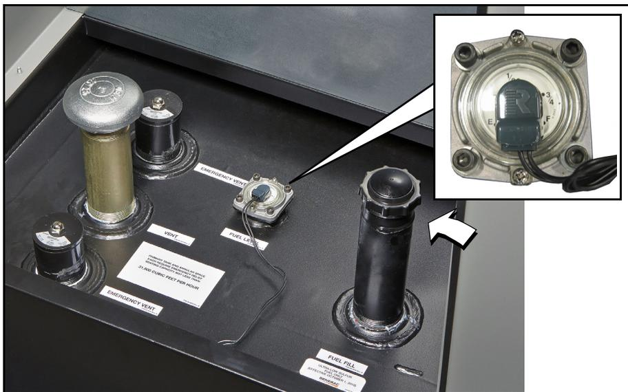
**Figura 5-7. Comprobación de nivel y llenado de combustible**
